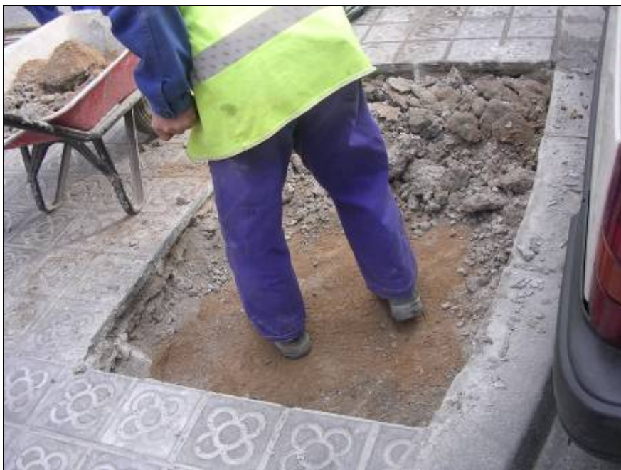
Foto.1: Inici dels treballs
