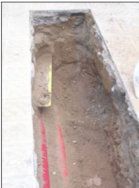
Foto.7 Detall dels serveis ja col·locats.
