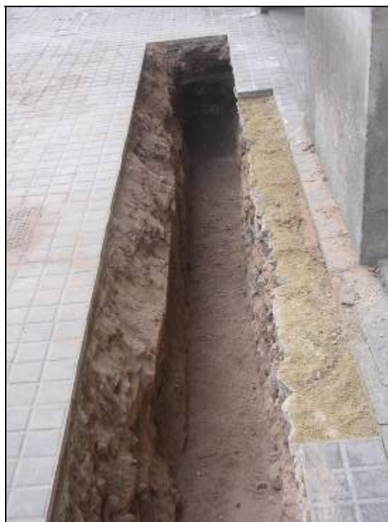
Foto.6: Detall de la rasa ja excavada.
