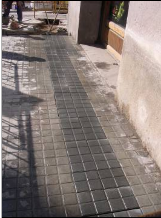
Foto.9: Detall de la rasa ja finalitzada.
