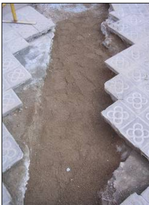
Foto.8: Detall de la rasa un cop col·locats i coberts els serveis amb sauló.
