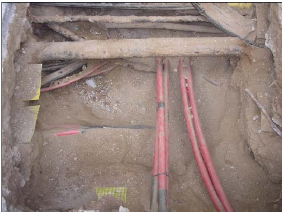
Foto.3: Detall dels serveis moderns localitzats al llarg de la rasa.
