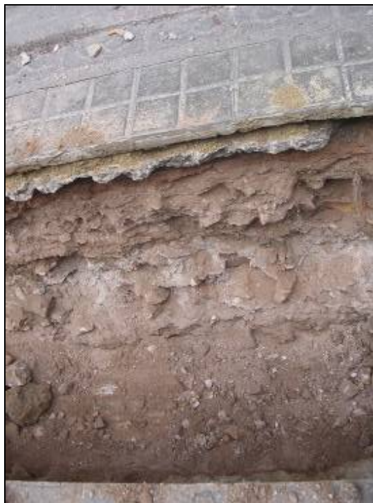
Foto.5 Detall de la secció de la rasa.
